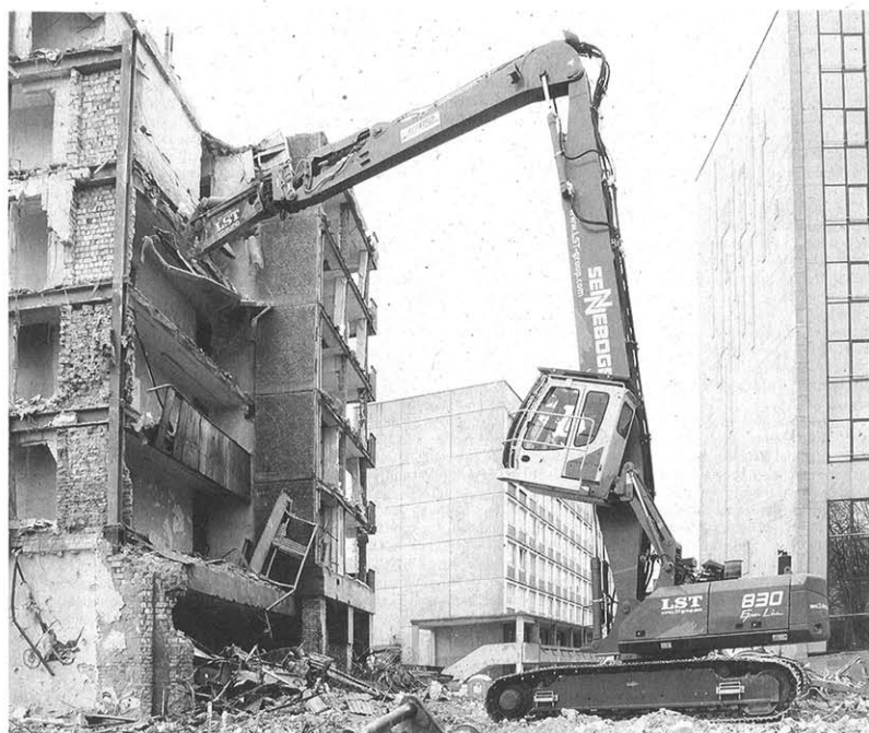
Die Schrottschere AD 3000 und die Multifunktions-Abbruchmaschine 830 R-HDD von Sennebogen bilden ein erfolgreiches Team für Abbruch und Rückbau, wie hier beim Rückbau eines leer stehenden Wohnkomplexes in Sachsen-Anhalt. Foto: LST
